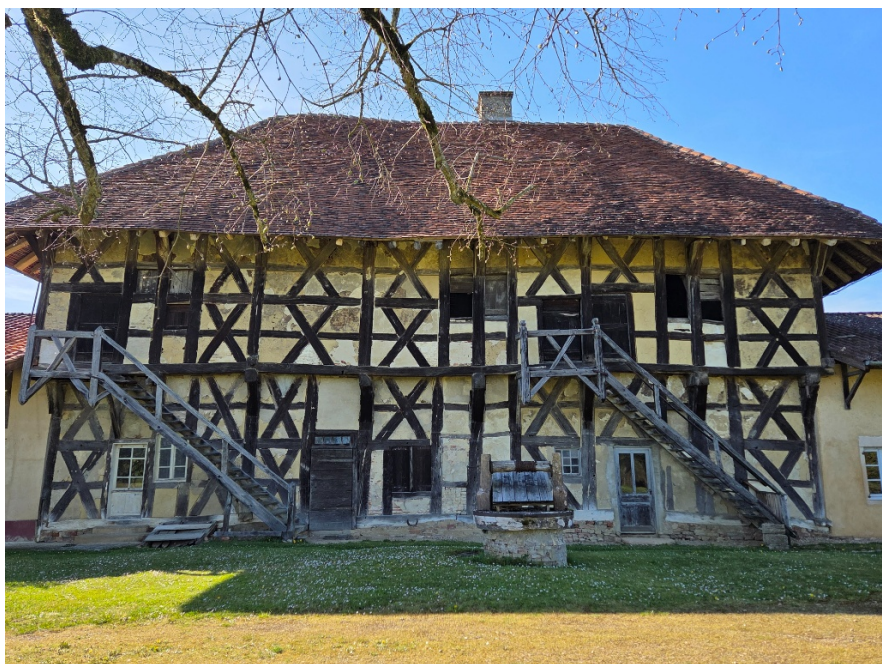
La grande façade à pans de bois du Manoir de Malmont (XV e siècle).
