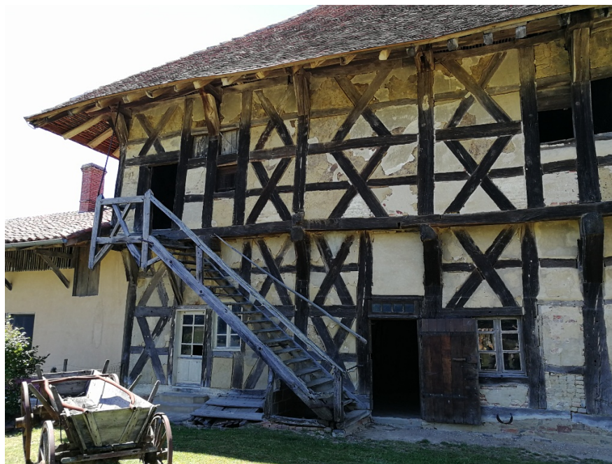
Détail des charpentes et des escaliers extérieurs en pan de bois.
